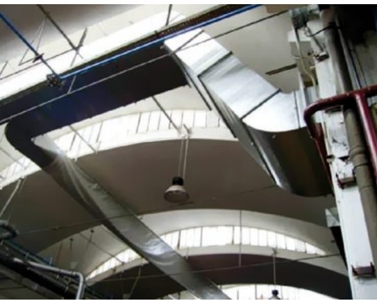
Bild 17: Hallenheizung mit Rückkühlleistung von 350 kW (Quelle Aichelin)
